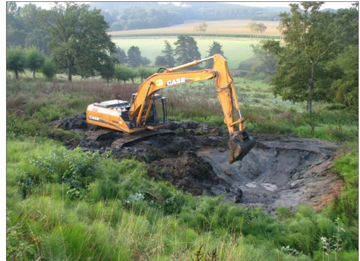
Figure 12: Curage d'une mare = enlever la couche de boue jusqu'au sol minéral. La matière superflue est généralement répartie dans les environs directs : La boue riche en nutriment peut rapidement donner lieu à une forte croissance de la végétation. Pour l'éviter, vous pouvez directement semer le ray-grass italien à croissance rapide (photo : Johan Carette).
